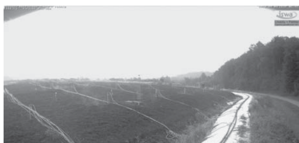
Abbildung 2 Austretende feuchte Luft oberhalb des Flächenbiofilters
